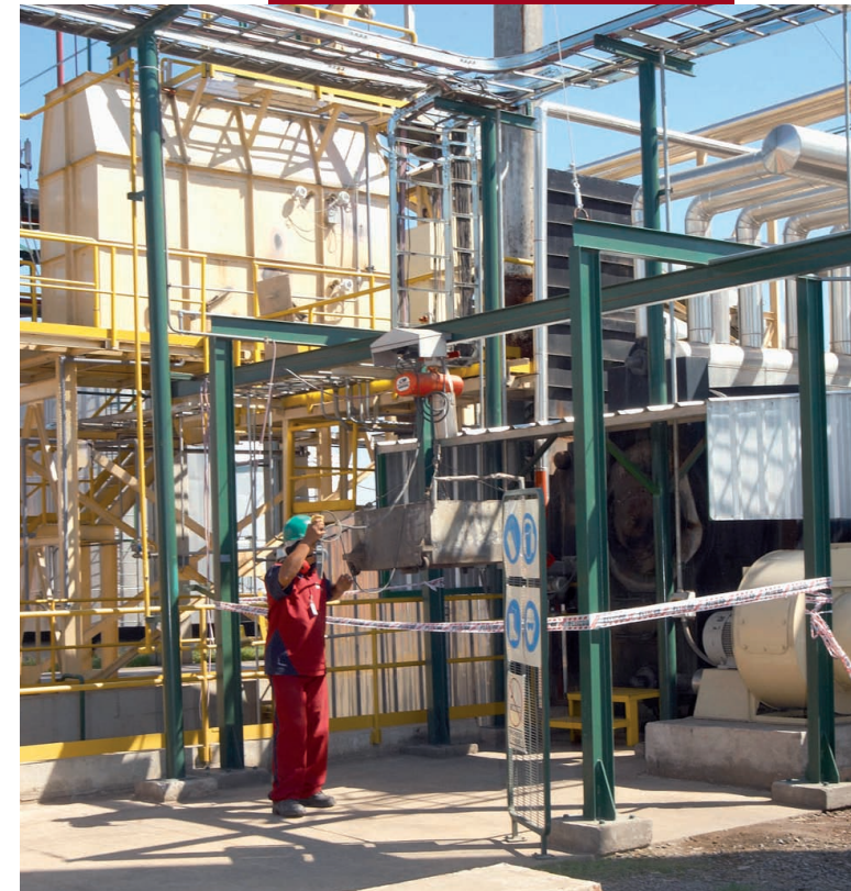
Limpieza de caldera industrial.
